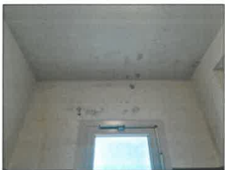
FOTO 100 - INFILTRAZIONI E MUFFE
