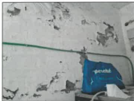
FOTO 105 - UMIDITA' E INFILTRAZIONI
