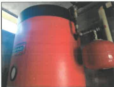
FOTO 53 - ACCUMULO ACQUA CALDA
