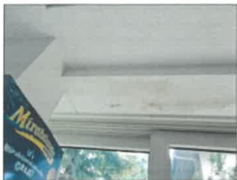
FOTO 97 - INFILTRAZIONE CONTROS
