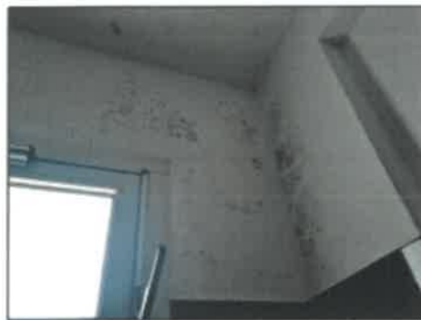
FOTO 102 - INFILTRAZIONI E MUFFE
