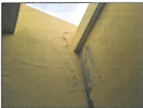
FOTO 101 - INFILTRAZIONE COPERT.
